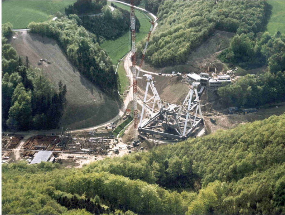
Abb. 2: Das 100-m-Radioteleskop Effelsberg im Bau. Der steile Abfall des Hügels von links oben bietet heute mit einem Zickzack-Weg einen einfachen Zugang bis zum Aussichtsplateau direkt vor dem großen Teleskop (Foto: MPIfR/Arge Krupp/MAN).
