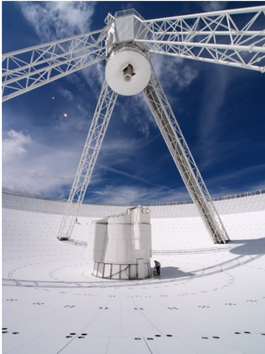
Abb. 4: Das Bild zeigt einen Teil der Oberfläche des Radioteleskops, die sich aus 2360 „Paneelen“ von je 3 m Länge zusammensetzt. Es sind insgesamt 9090 Quadratmeter Oberfläche, die eine Schüssel von 100 m Durchmesser bilden. Empfänger zur Aufnahme der Radiosignale sitzen an zwei verschiedenen Stellen im Teleskop. Ein Teil der Empfänger sitzt oben im Brennpunkt, an der Spitze der vier Stützbeine 30 m über der Schüssel, ein weiterer Teil in der Kabine im Zentrum der Schüssel – mit einer Person direkt rechts daneben für den Größenvergleich (Foto: Norbert Tacke).
